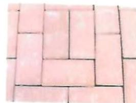
Calçadas externas contornando a edificação e calçadas da área de lazer em piso de concreto intertravado, tipo paver. Modelo tipo platô, 19,9X10X4cm. Cor: Natural/ Cinza.
